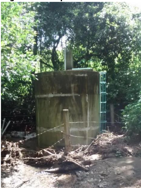
Figura 3. Pozo profundo en río intermitente y primer tanque de agua.
