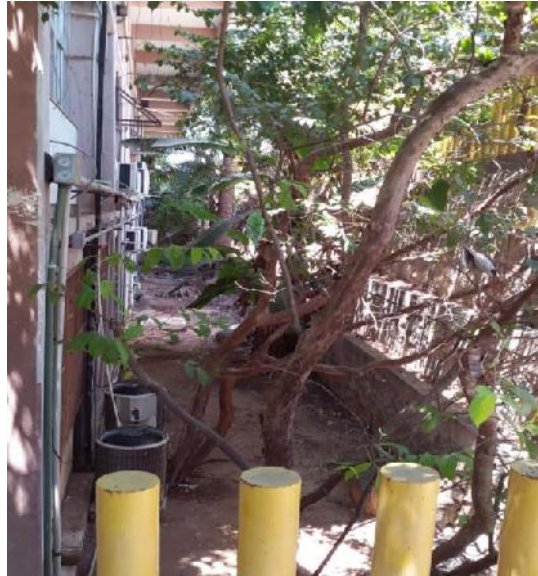
Fig. 6.36. Pasillo trasero de la Unidad de Ciencias de Desarrollo Regional
