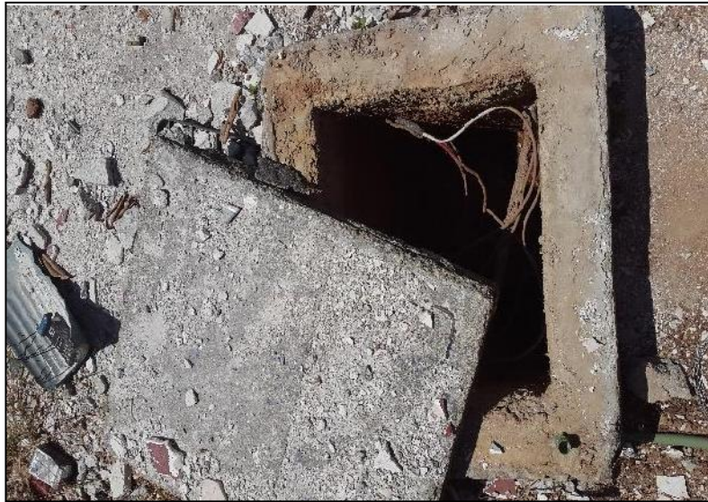
Fig. 6.14. Instalación de corriente eléctrica en la Preparatoria N°2
