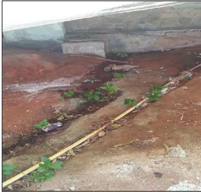
Fig. 6.15. Fuga en las tuberías de agua de la Preparatoria N°2
