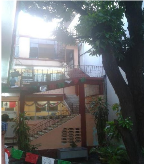
Fig. 6.38 Pasillo de la Coordinación General Zona Sur
